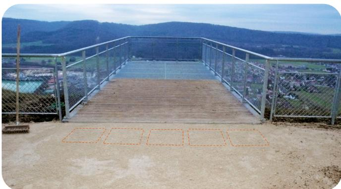
Le capteur DALLE sent les vibrations créées par le pas des passants. Compatible avec tous types d'environnements il permet de comprendre les habitudes des usagers. Devant un point de vue il permet d'en connaître la fréquentation.
